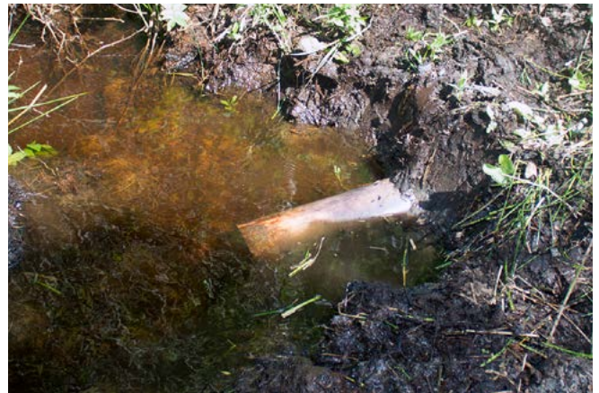
Utlopp från ett täckdike före underhåll i diket. Foto: Markus Hoffman
