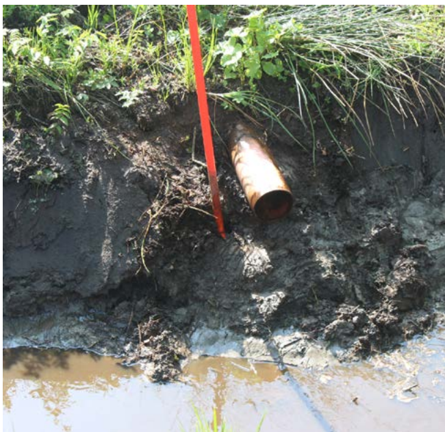
Utloppet efter underhåll. Lägg märke till att det ligger 2–3 dm över botten. Foto: Markus Hoffman
